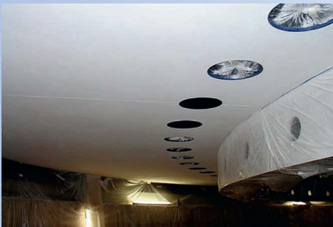
Die auf Gipsplattenuntergrund aufgeklebten und anschliessend ausgefugten Akustikträgerplatten wurden mit Baswa-Top Feinputz beschichtet.
