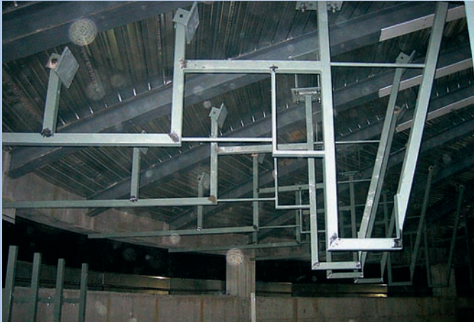
Blick vom Deckengerüst auf die Kuppel des Ballsaales. Im Vordergrund die bauseitige Unterkonstruktion des Metallbauers der zu beplankenden Deckenrandbereiche.
