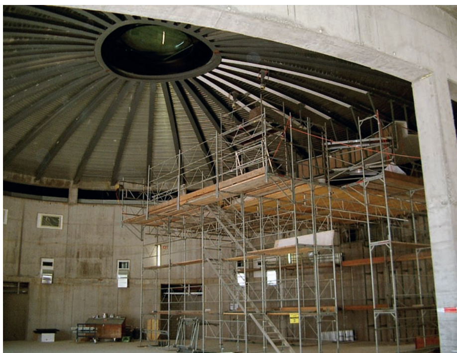
Der eiförmige Ballsaal im Rohbau ...
